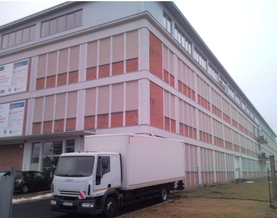
Bild 1 Das Gebäude des Zentralarchives (CERS)
