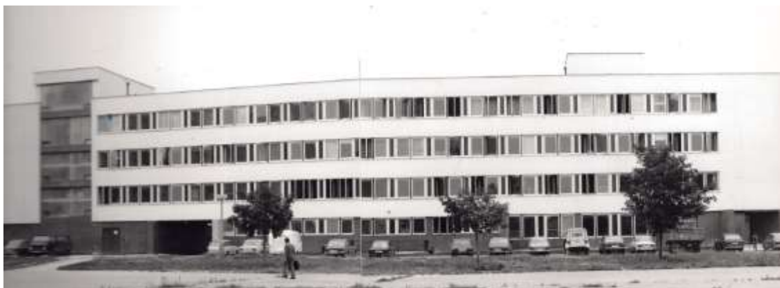
Obr. 17 Bočný pohľad na novú budovu GÚ n. p. na Chlumeckého 4 v roku 1982 [2]
