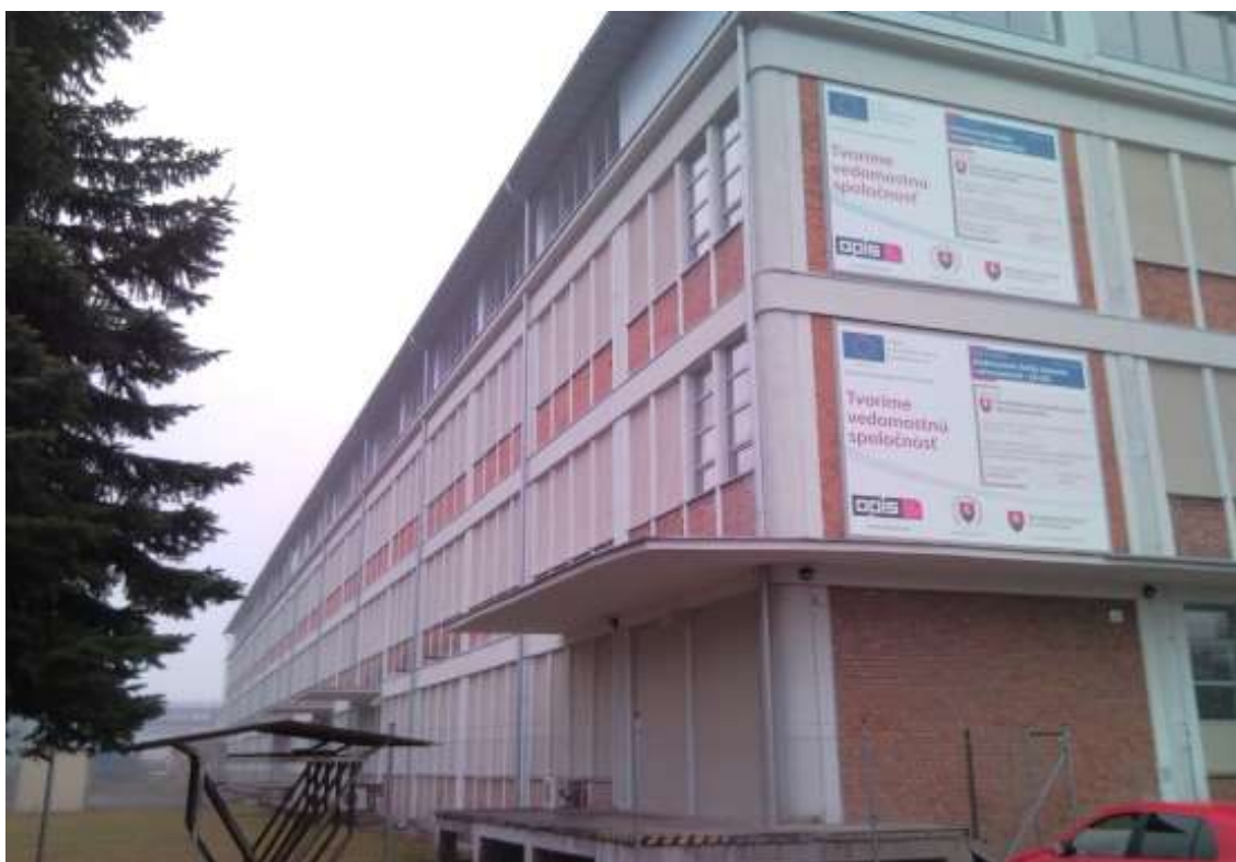
Obr. 59 Budova pracoviska CERS v Liptovskom Mikuláši [68]
